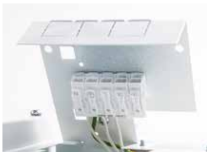
Asennus kytkentärimalle (DALI)
